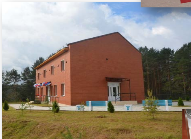
Здание нового фельдшерско-акушерского пункта (пос.Приветнинское, Выборгский район)
