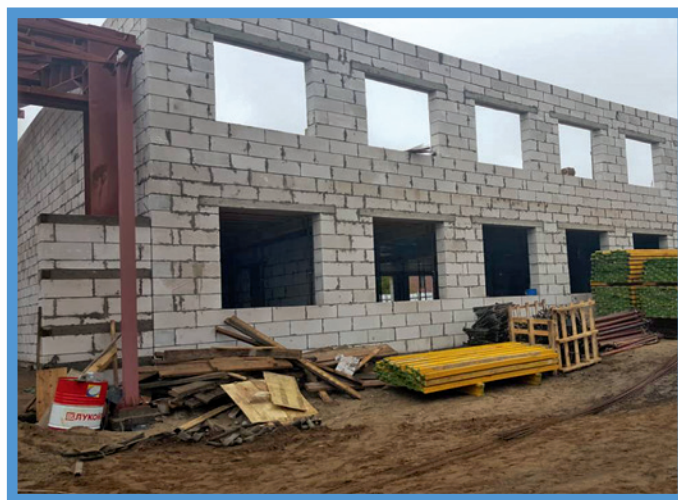
Строительство пожарного депо в г.Сясьстрой
