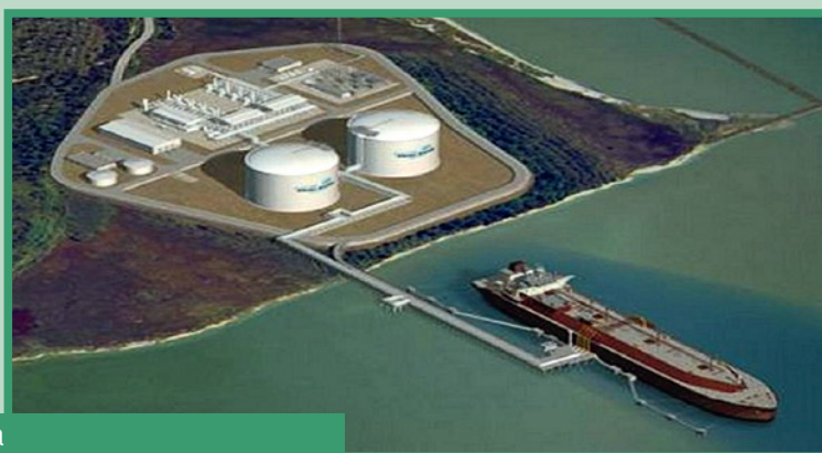
Строительство контейнерного терминала
