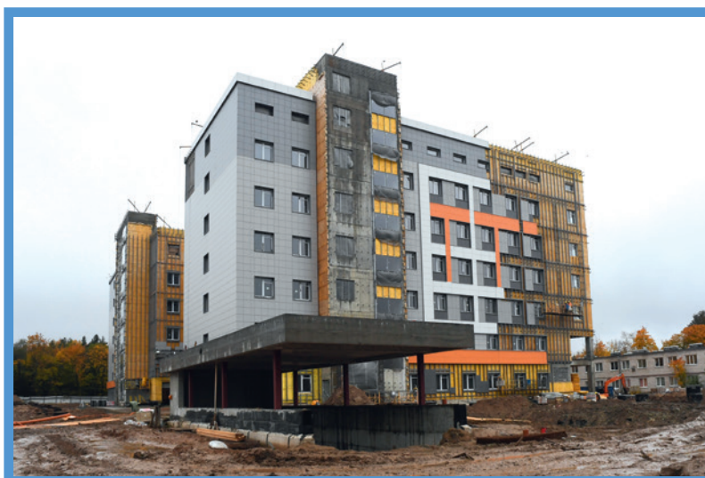
Строительство перинатального центра в г.Гатчина
